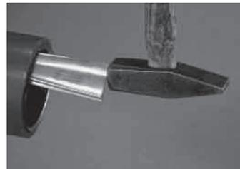
Proseguire con l'introduzione dell'inserto metallico fino a che il bordo sporgente sia in contatto con l'estremità del tubo.
